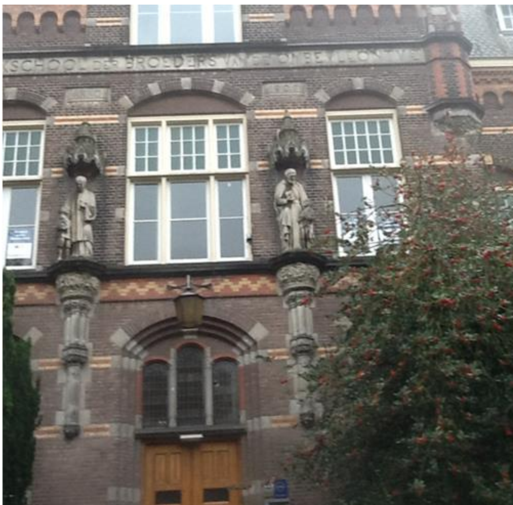
Figuur 11 Hoofdingang voormalig klooster
